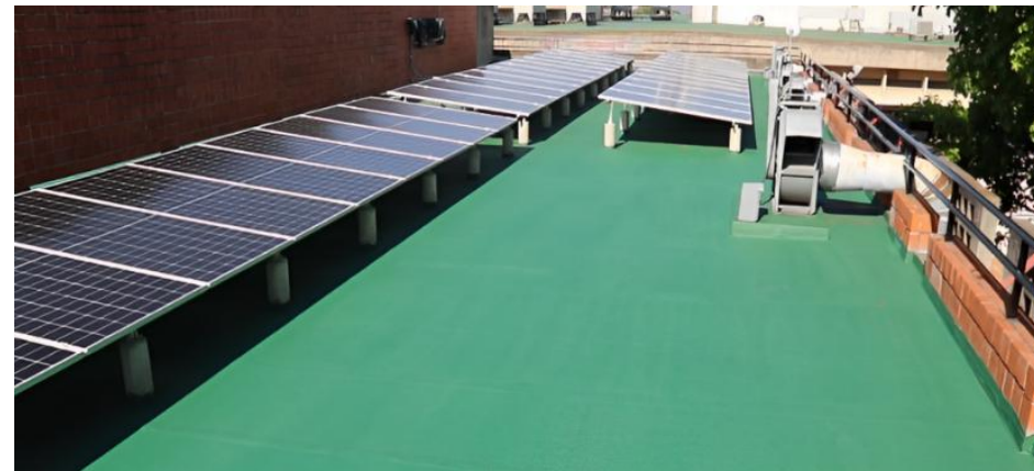
Mantenimiento 36 paneles y ampliación del sistema solar fotovoltaico
